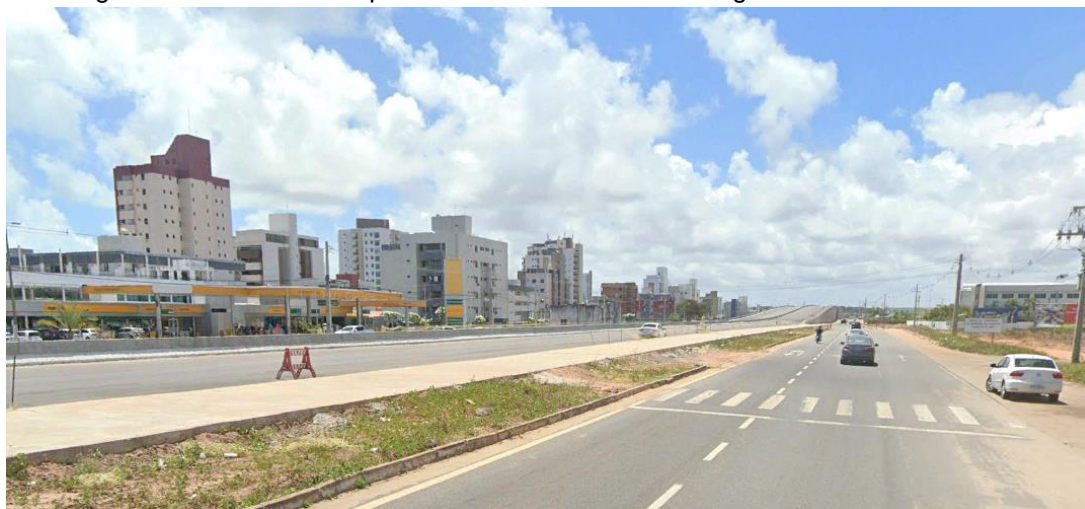
Figura 38 - Travessia de pedestres existente na via marginal da Rodovia BR-230
