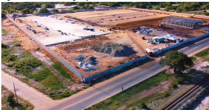
Figura 41 - Pátio de Regulação de Caminhões do Porto de Cabedelo
