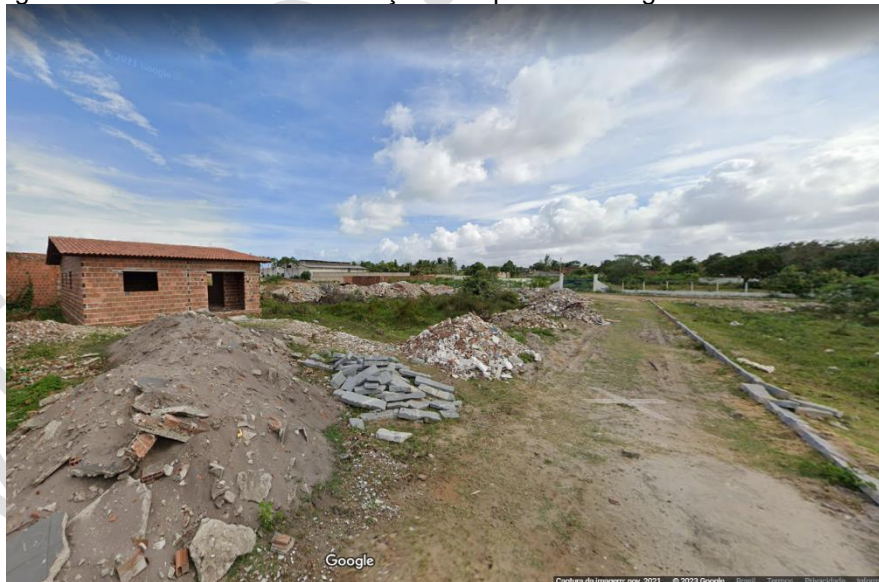
Figura 14 – Resíduos de Construção Civil próximo a região Recanto do Poço
